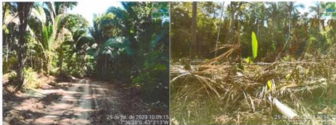
Figuras 26 e 27: Vista da do ramal na qual se observa manutenção recente e do corte de algumas árvores para alargamento do mesmo.
