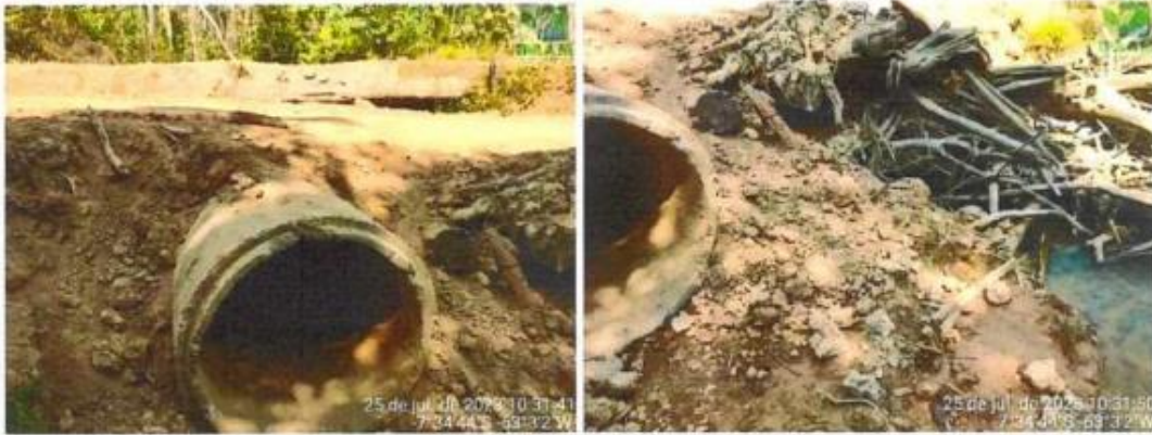
Figuras 9 e 10: Manilhas de concreto instaladas acima da cota do curso d'água.
